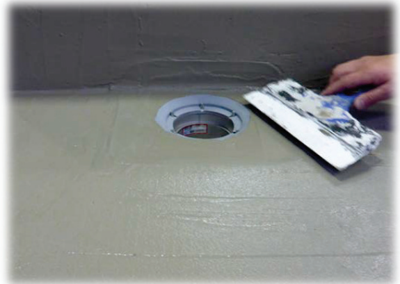
Slukmansjett og smøremembran påføres av membranlegger
