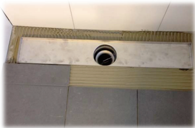
Rammen entres i klemringen og limes i flislim / avretningsmasse
