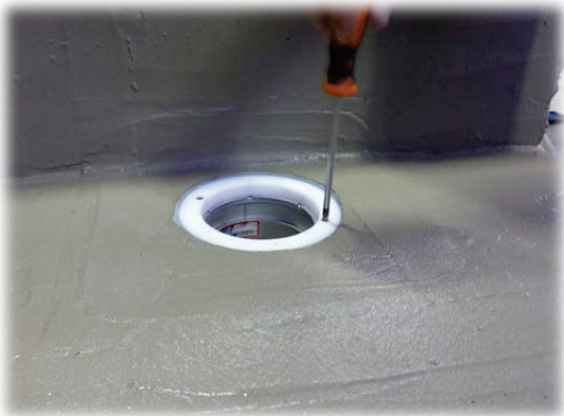
Membranlegger monterer klemring
